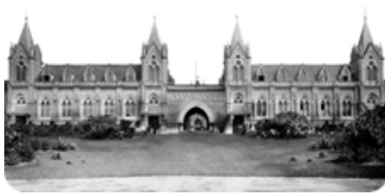
Santa Casa de Misericórdia de São Paulo
